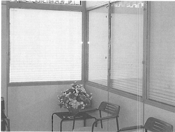
Fig. 8. Tabique prefabricado a base de dobles cristales que proporciona un adecuado aislamiento térmico y acústico.
